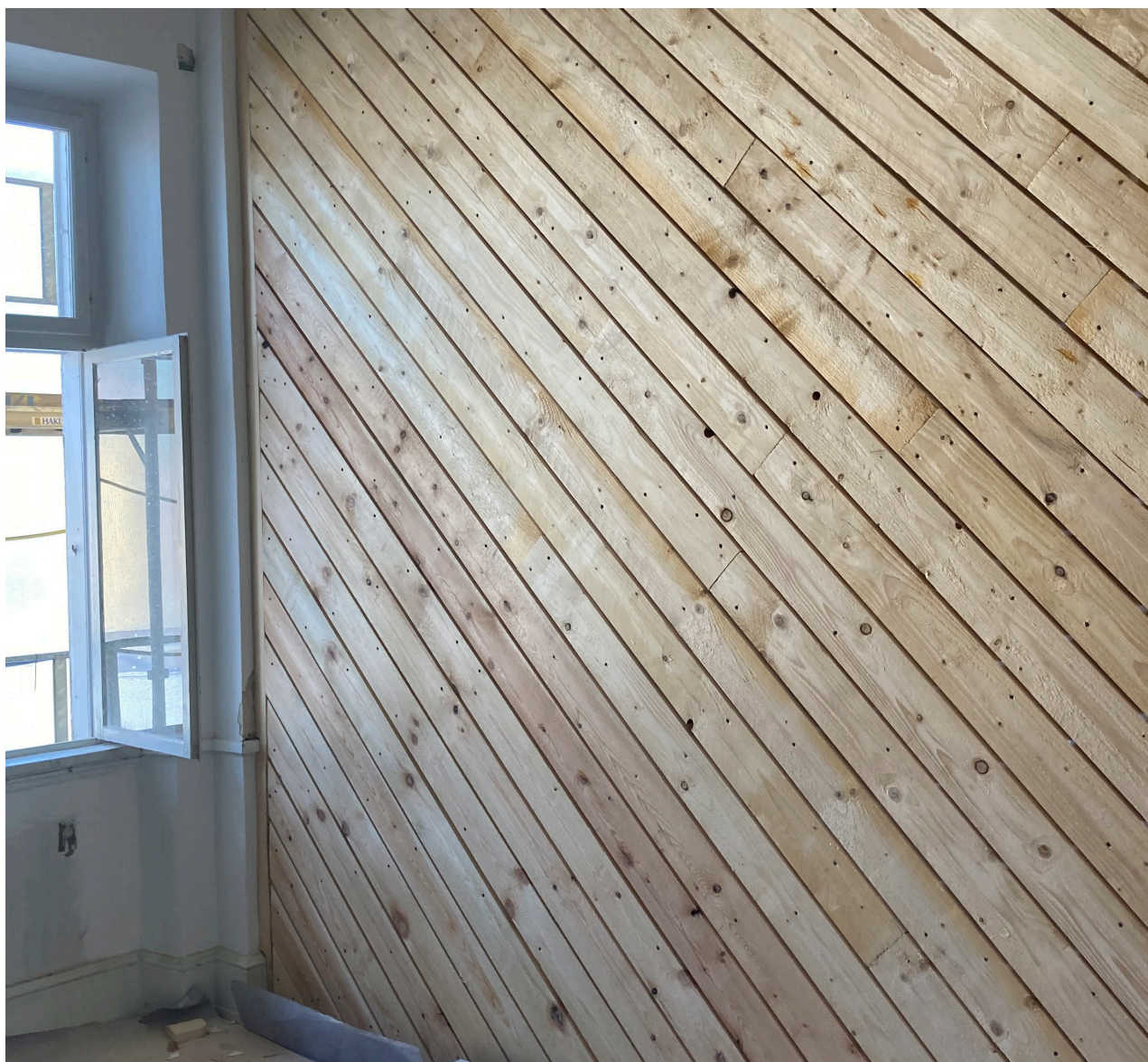
Billede 6. Nye bræddeskillevægge på Rektorboligens 1.sal. Foto: ERIK
